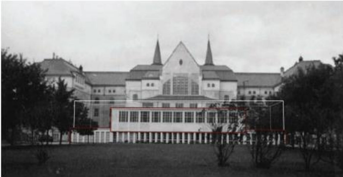
Figur 8: Grepet innebærer riving av eksisterende kontortilbygg i 2. og 3. etasje fra 1960-tallet, og at nytt tilbygg får gesimshøyde på opprinnelig nivå (bygningssdel med valmtak), slik at aulavinduet blir mer synlig enn det er i dag. Bildet er fra 1950-tallet, da biblioteket var bygget, men ikke kontordelen.
