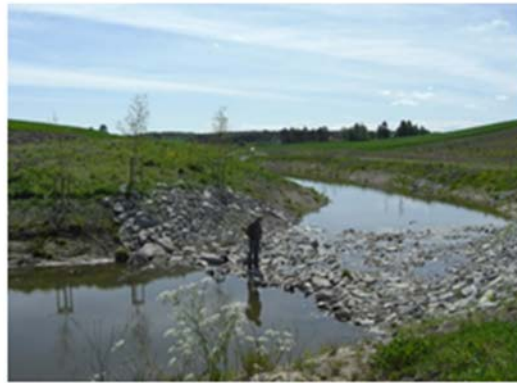
Nyanlagt fangdam med beplantning i en sidebekk til Kråkstadelva i Ski, Akershus
