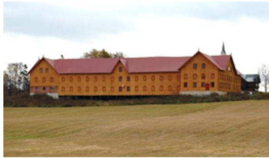
Horne gård, Stange i Hedmark, drift med storfe og korn. En av Hedmarks største driftsbygninger, viktig som del av tun og landskap.
