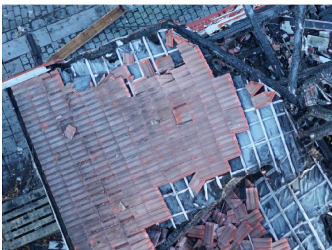
Vertikalfoto fra drone av deler av branntomta i Storgata 81.
