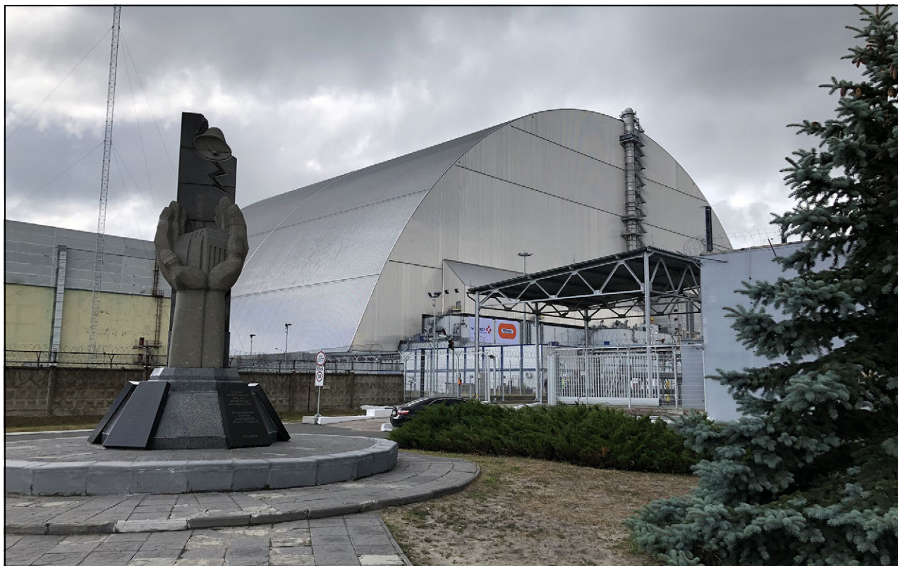
Figur 4.1 Tsjornobyl i 2019. Overbygningen over den forulykkede reaktoren ble mulig gjennom internasjonal finansiering koordinert av EBRD. Dekommisjonering av reaktoren gjenstår fortsatt.
