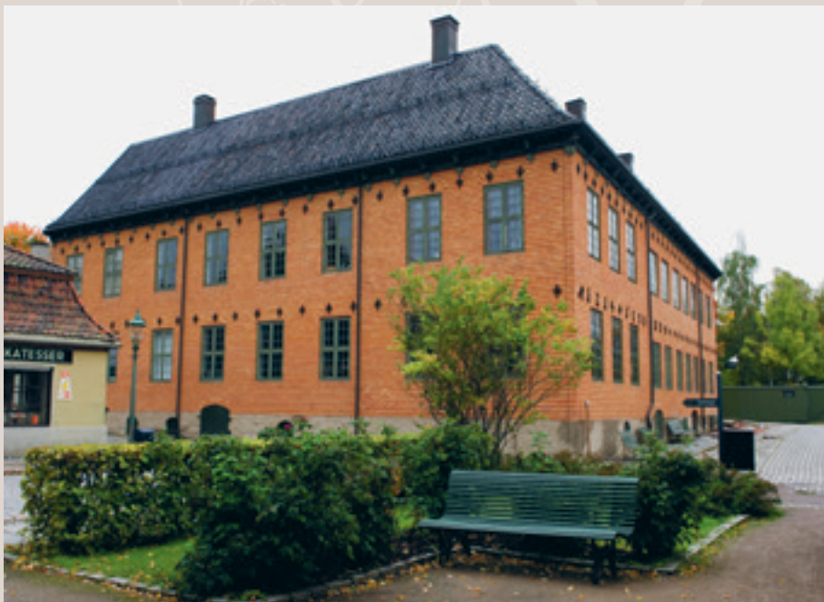
Finansdepartementet flyttet inn i Generalitetsgården i Dronningensgate 15 i 1814. Departementet holdt til i andre etasje hvor departementets nær 40 ansatte hadde over 13 værelser til disposisjon. Gården ble revet i 1916, men ble senere (delvis) gjenreist på Norsk Folkemuseum på Bygdøy. Den huser i dag Apotekmuseet. Foto: Anne-Lise Reinsfelt, Norsk folkemuseum.
