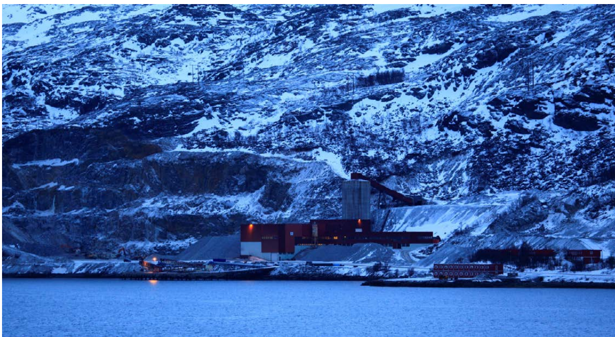
Figur 3: Dagens virksomhet i det gamle gruveområdet ved Øyen. (Foto: Terje Aksberg).
