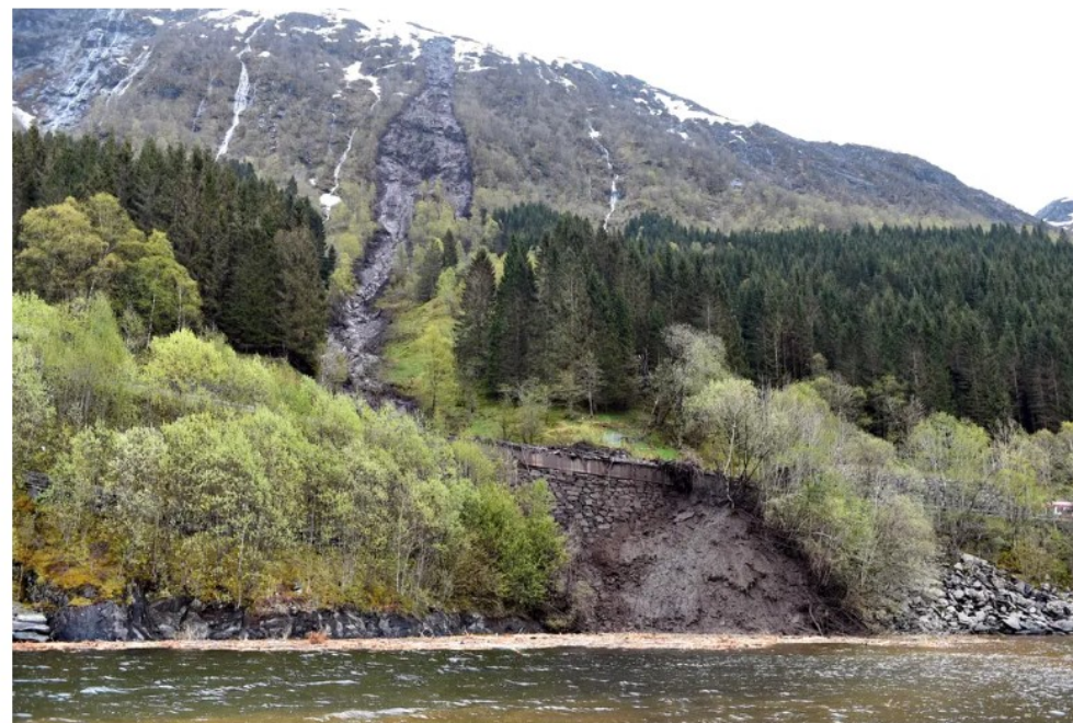
STENGT: E16 og Bergensbanen er stengt på grunn av et ras som har gått over veien og jernbanelinjen i Vaksdal. FOTO: FRED IVAR UTSI KLEMETSEN
