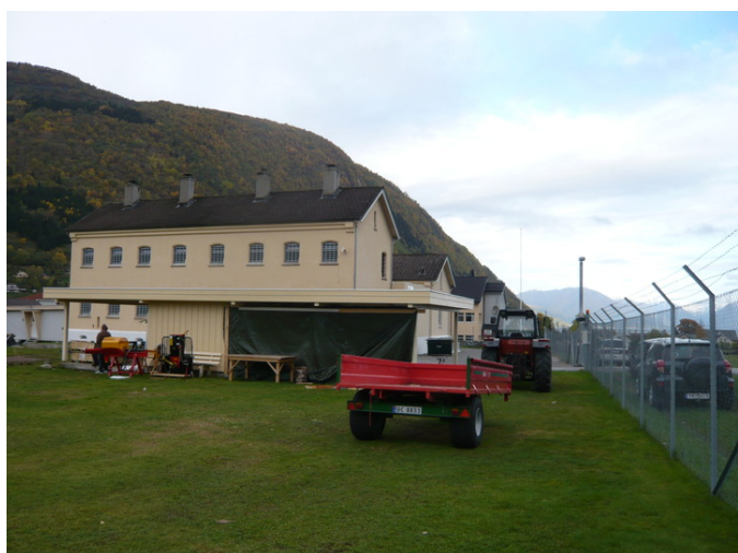
Vik fengsel. Sett fra sørøst. Uthus i forgrunnen. Opphavsrett: Statsbygg.
