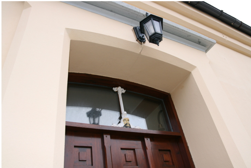
Forbygning. Detalj inngangsparti. Opphavsrett: Statsbygg.
