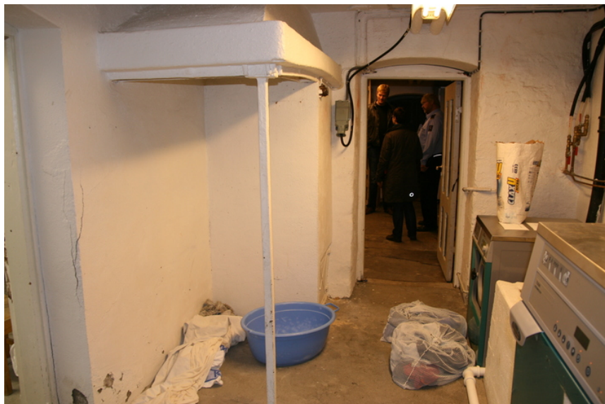
Kjeller under leiligheten. Opphavsrett: Statsbygg.
