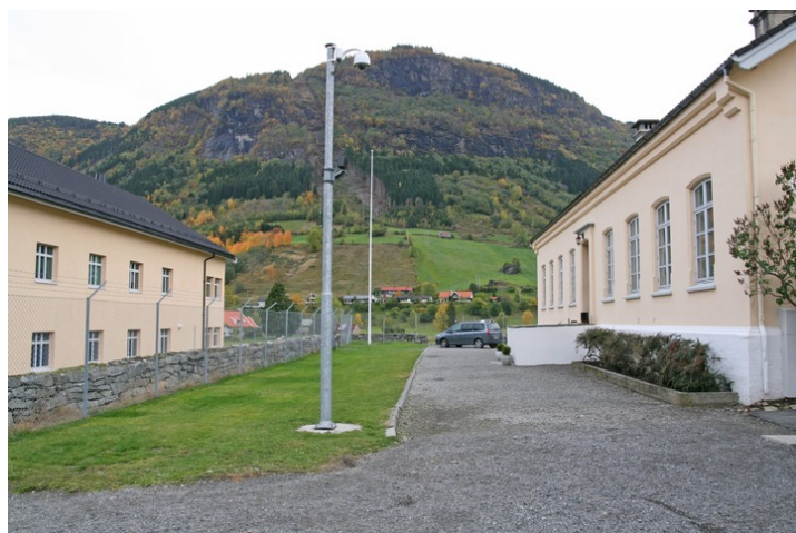
Eldre steinmur nord og øst for forbygningen. Opphavsrett: Statsbygg.
