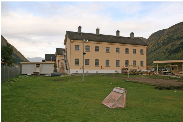
Cellebygning, fasade mot sør. Til venstre arbeidsbrakke. Forbygning og nytt cellebygg bakenfor. Opphavsrett: Statsbygg.
