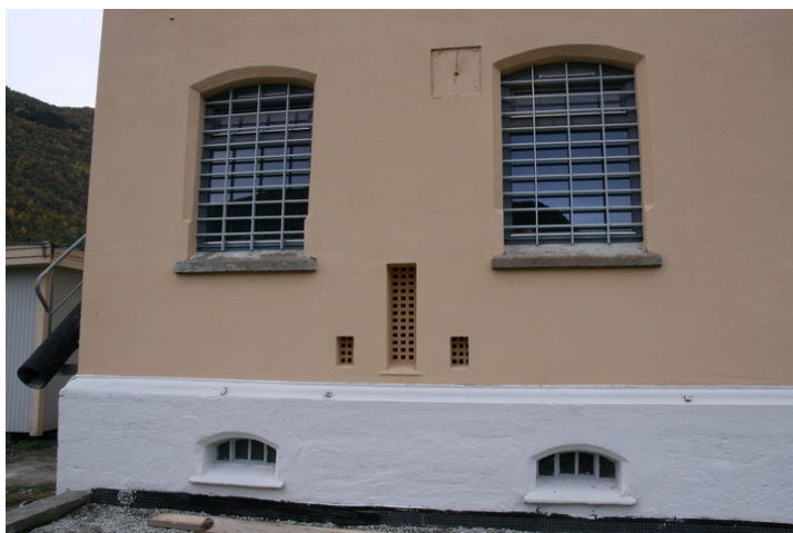
Detalj, yttervegg cellebygning: ventilasjonsluker. Opphavsrett: Statsbygg.
