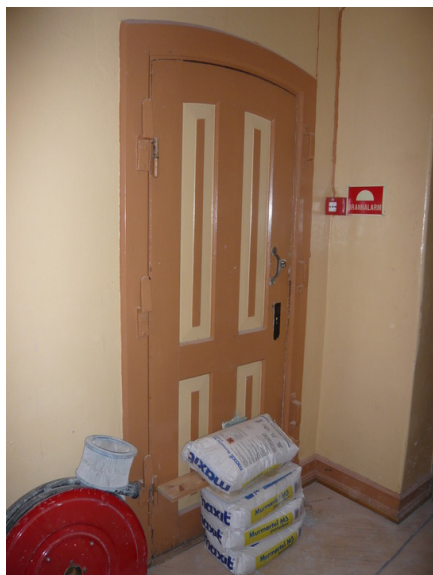
Dør i mellomgang. 2008. Opphavsrett: Statsbygg.
