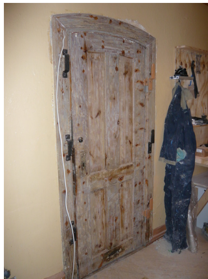
Dør i mellomgang. 2008. Opphavsrett: Statsbygg.
