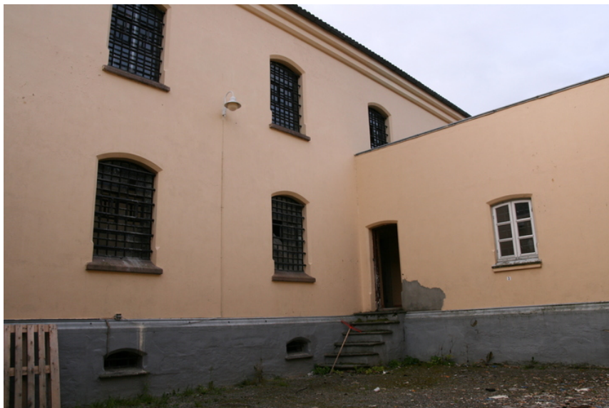
Mellomgang sett fra den opprinnelige luftegården. Opphavsrett: Statsbygg.
