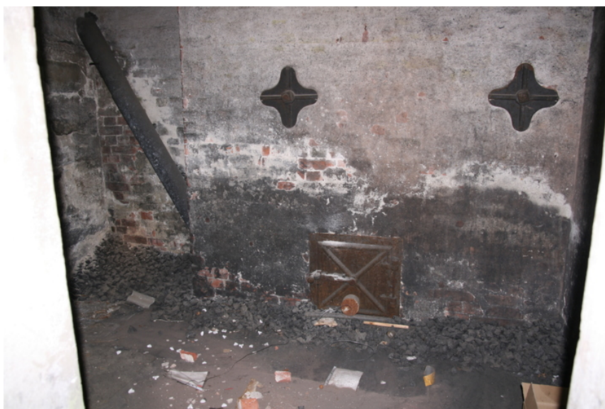
Spor av fyring i kjellerom. Opphavsrett: Statsbygg.
