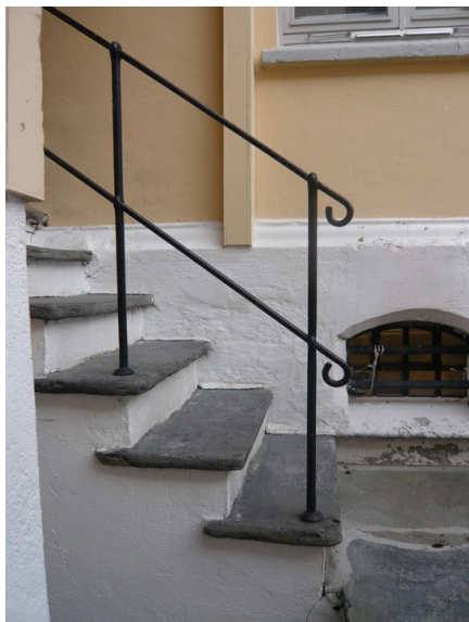
Detalj av trapp mot kjøkkenhagen. Opphavsrett: Statsbygg.
