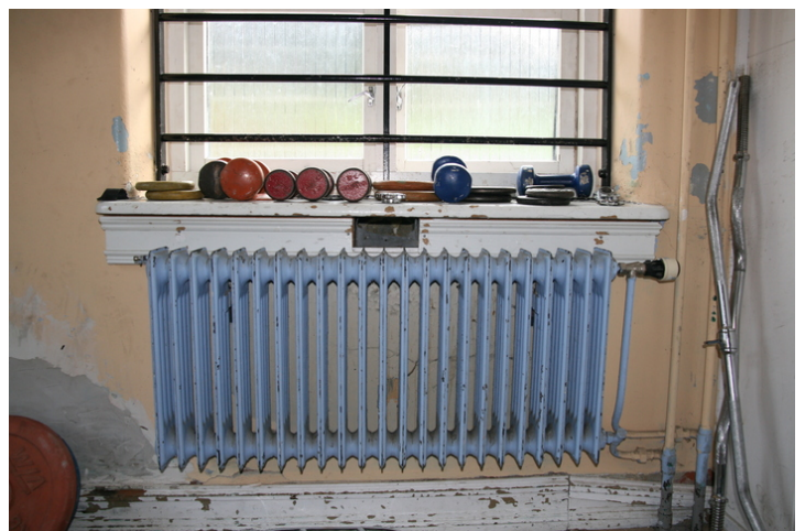
Vindu og listverk. Tidligere rettsal. Foto: Statsbygg. Opphavsrett: Statsbygg.
