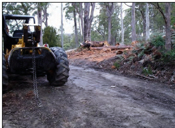
Figur 8.2 Ulovlig hogst utgjør en stor andel av avskogingen i tropiske land.
