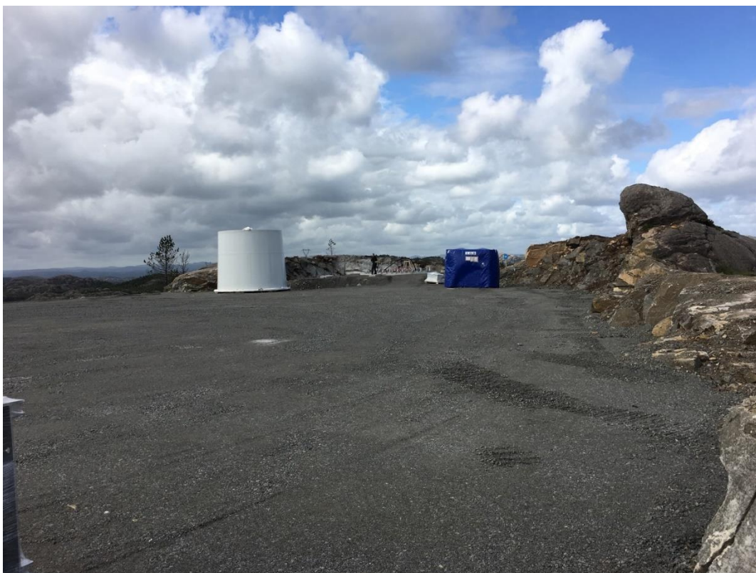
En sprengt fjelltopp – oppstillingsplass under bygging
