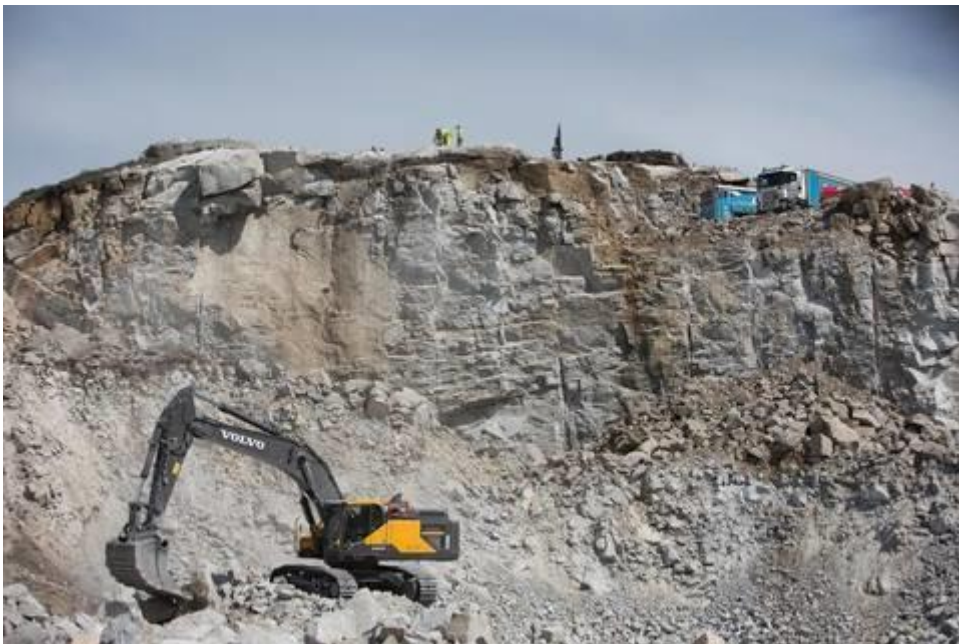
Tonstad vindkraftverk i Sirdal – legg merke til den store trucken oppe på det sprengte berget – bildet er tatt i september 2019.
