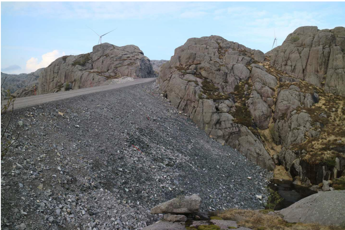
40 m. høy fylling – merk vannet
