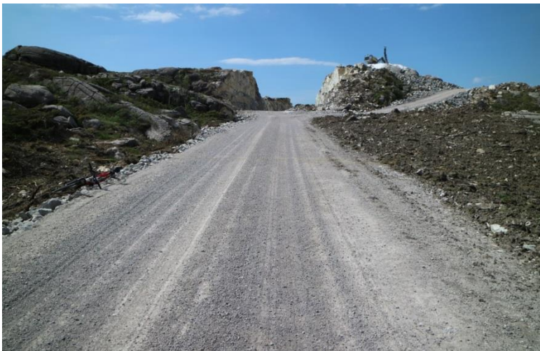
Veianlegg, Bjerkreim vindkraftverk 2018
