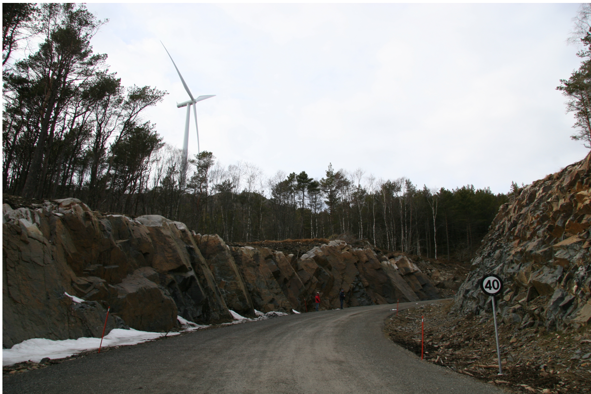
Fra Lista «Vindpark»: 10 m bred kjørebane med eksempel på skjæring, foto: FNF Rogaland
