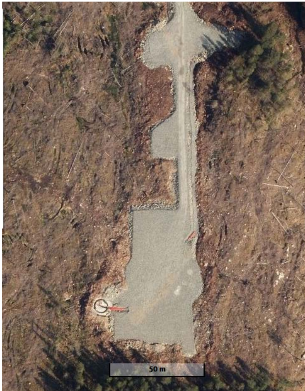
Flybilde viser oppstillingsplass med turbinfundament og lagringsplasser ved turbinpunkt 8 i Joarknatten vindkraftverk i Marker kommune. (Kilde: Norgeskart)
