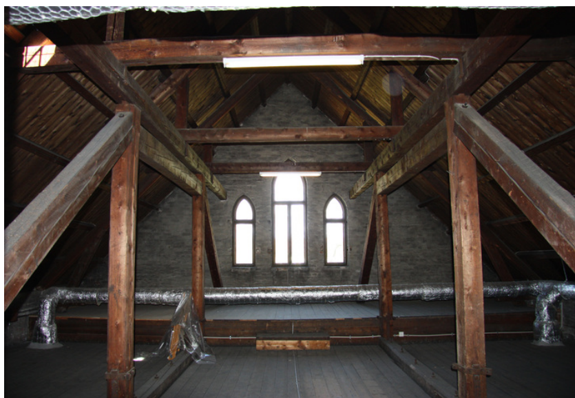
Loftet over fløyen har synlige bjelkekonstruksjon. I gavlveggen er det tre gotiske vinduer. Opphavsrett: Statsbygg.
