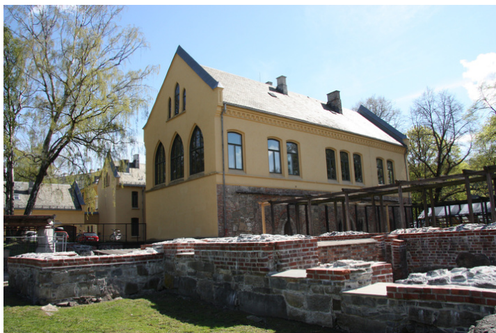
Nord- og vestfasaden av fløyen med ruinene etter Olavsklosteret i forgrunnen. Gavlfasadene har gotiske vinduer. Opphavsrett: Statsbygg.
