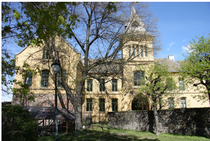
Sørfasaden med tårnet vender mot Minneparken. Til venstre er den tverrstilte fløyen som er bygget på ruinene av Olavsklosteret. Opphavsrett: Statsbygg.
