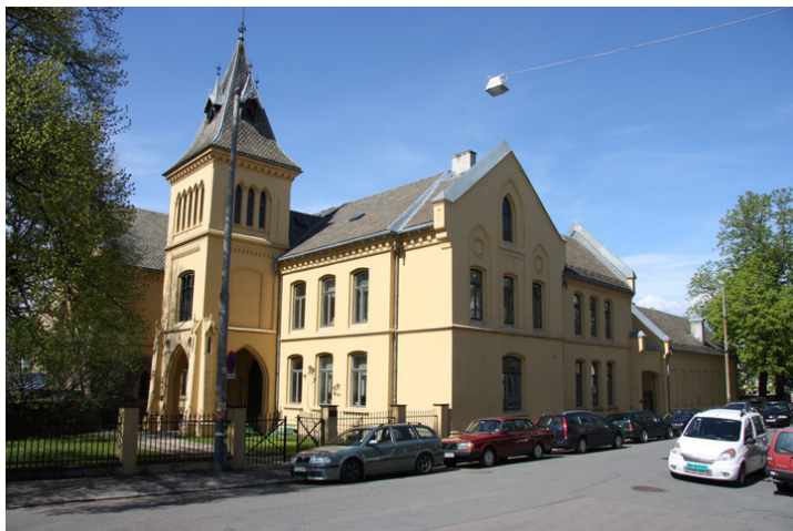
Hele anlegget sett fra Egedes gate. Hovedinngangen er i tårnet. Opphavsrett: Statsbygg.
