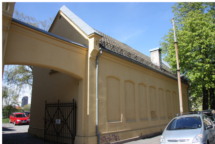
På østfasaden som vender ut mot Egedes gate er vindusåpningene blendet. Opphavsrett: Statsbygg.
