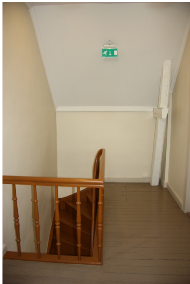
Lite er bevart, men tregulvet er av eldre dato. Opphavsrett: Statsbygg.
