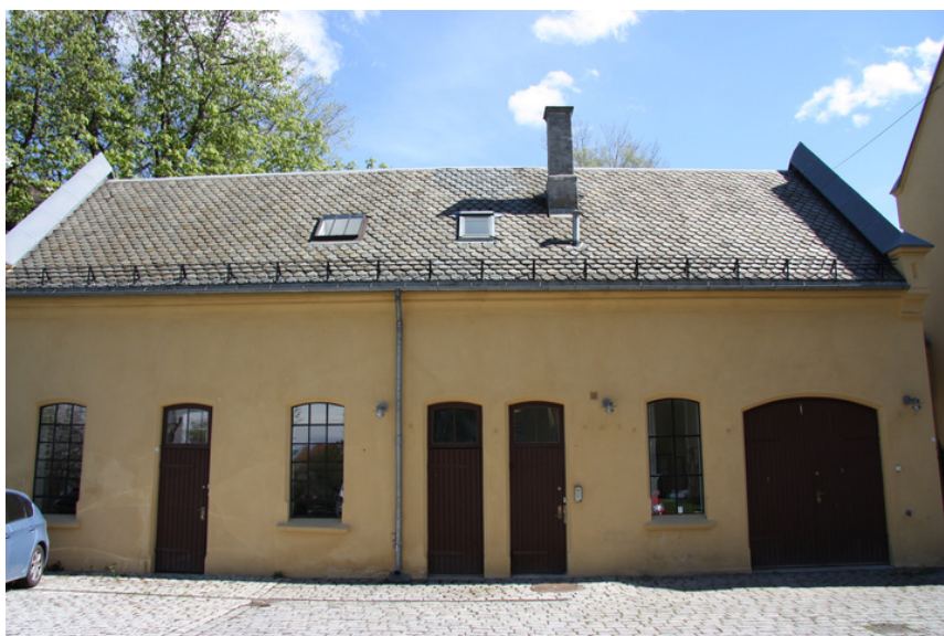
Fasaden mot gårdsplassen. Porten til høyre er tilbakeført i forbindelse med rehabiliteringen i 2006. Vinduene har originale jernsprosser. Opphavsrett: Statsbygg.
