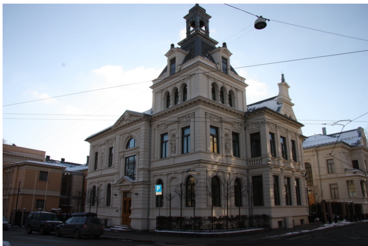
Bildet er tatt i krysset Riddervoldsgate og Inkognitogaten. Til høyre skimtes statsministerboligen i Inkognitogaten 18 og til venstre er Parkveien 45. Opphavsrett: Statsbygg.
