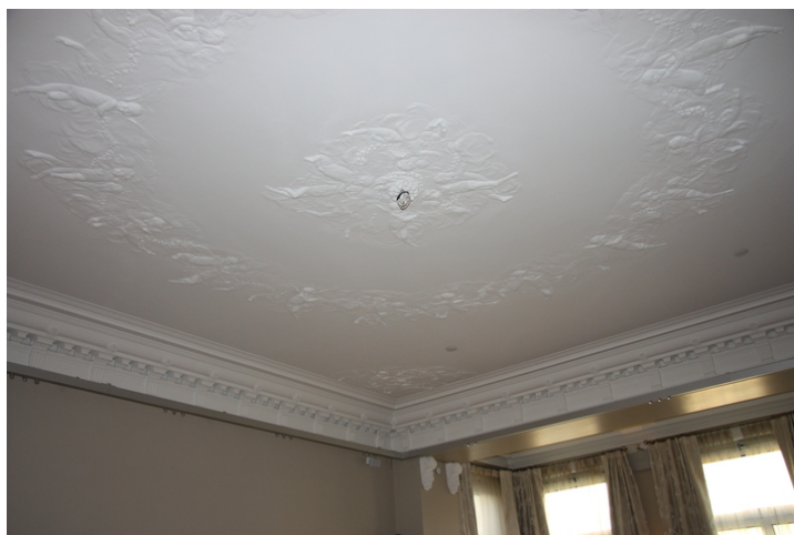
Gipstaket i presserommet er unikt ved at det er modellert på stedet. Resten av rommet er modernisert. Opphavsrett: Statsbygg.
