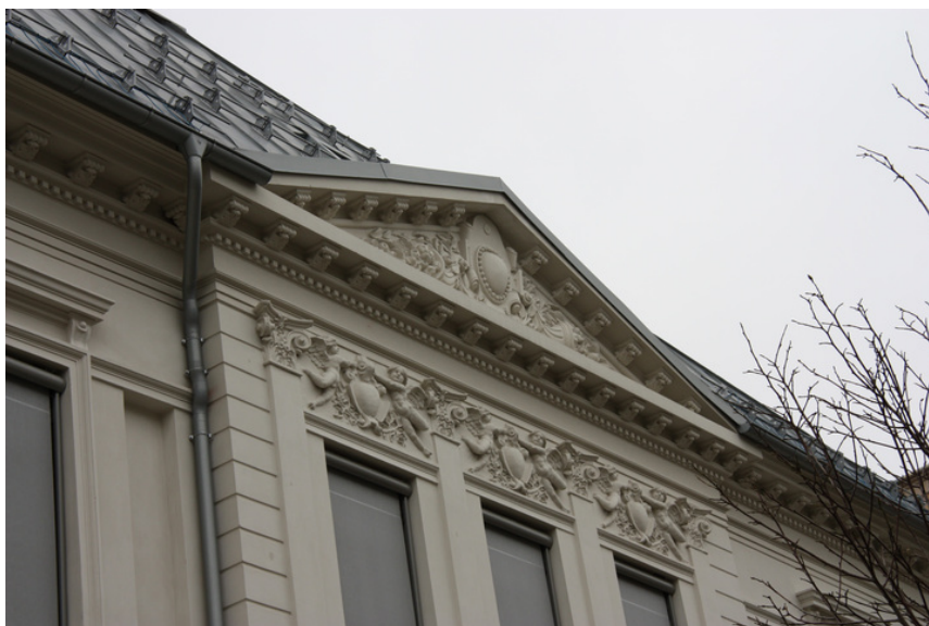
Tympanonfelt med relieffer på sørvestfasaden. Opphavsrett: Statsbygg.
