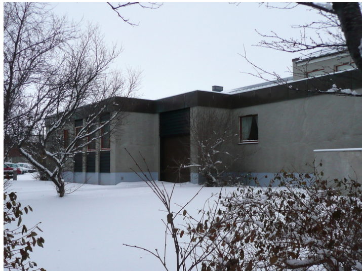
Vaktmesterboligen til venstre og fylkesmannsboligen til høyre er skilt med fylkesmannens garasje i midten. Opphavsrett: Statsbygg.
