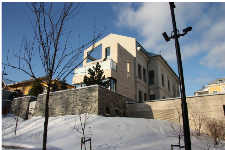
På nordøstfasaden ser man tydelig skillet mellom den gamle villaen og det nye tilbygget. Garasjeanlegget til høyre er ikke omfattet av vernet. Opphavsrett: Statsbygg.
