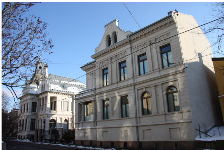
Fasadene mot Inkognitogaten i nordvest og den glatte sørvestfasaden mot nabotomten. Opphavsrett: Statsbygg.
