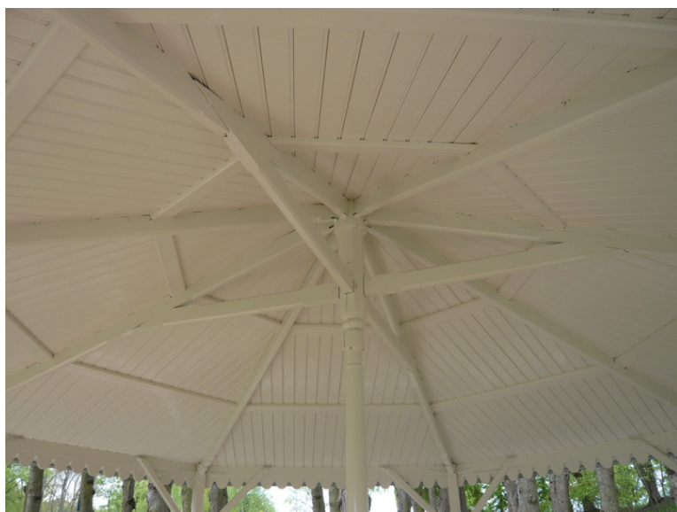
Takkonstruksjon. Opphavsrett: Statsbygg.
