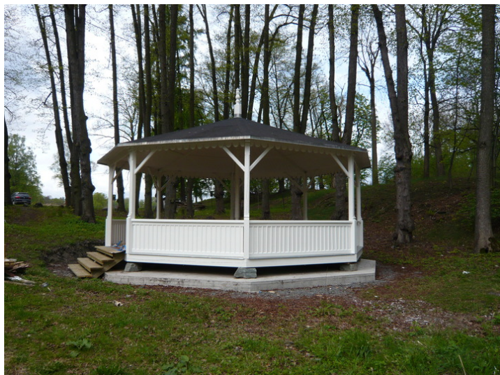
Paviljongen nordvest for kafeen på Rohdeløkken. Opphavsrett: Statsbygg.
