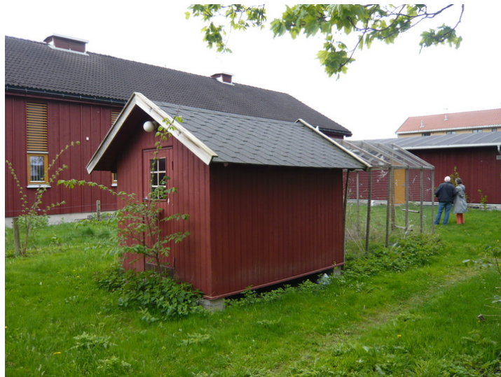
Fasade mot nord. Opphavsrett: Statsbygg.
