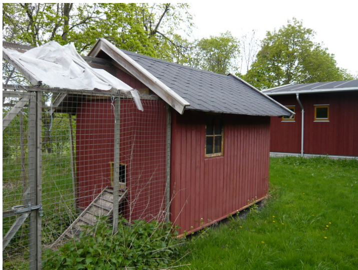
Hønehuset ligger mellom to av sidefløyene til stallbygningen. Opphavsrett: Statsbygg.
