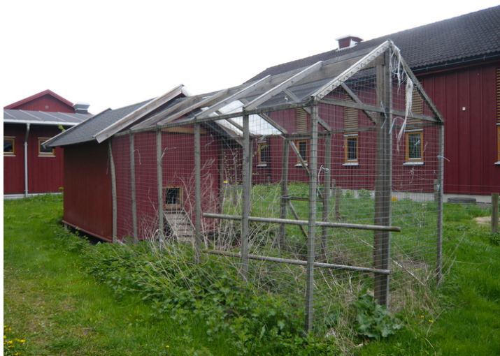
Fasade mot vest. Stallbygningens hovedfløy til høyre. Opphavsrett: Statsbygg.
