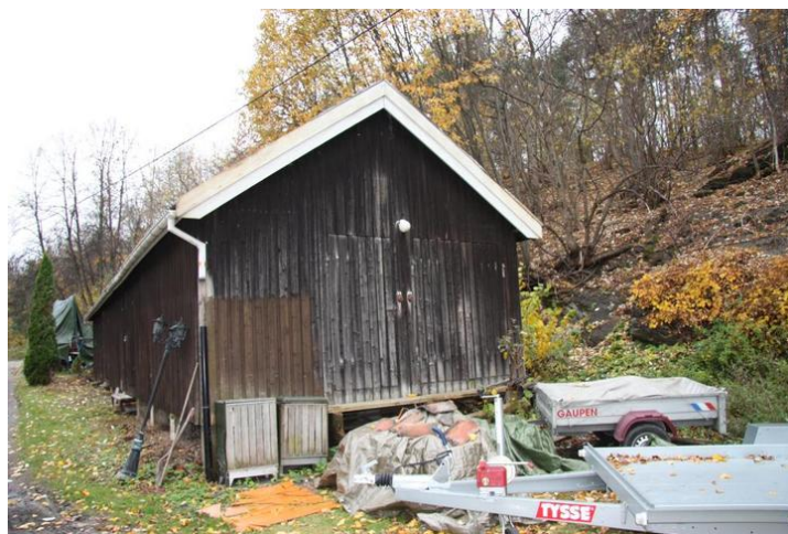
Uthuset ved gartneriet, gavlvegg. Opphavsrett: Statsbygg.
