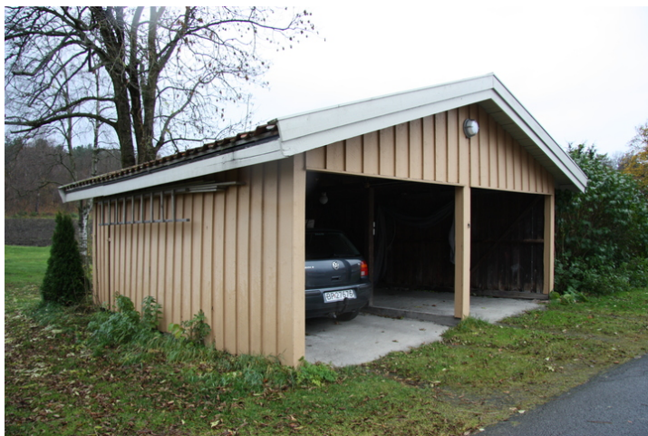
Garasjen er uten porter. Opphavsrett: Statsbygg.
