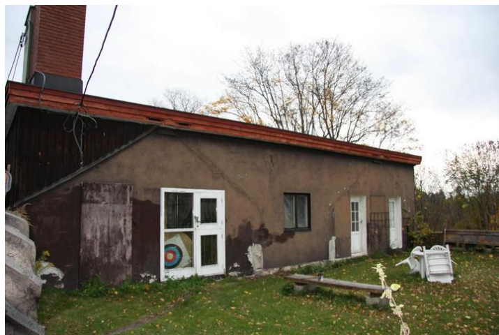
Fyrhusets fasade mot drivhusene som nå er revet. Opphavsrett: Statsbygg.
