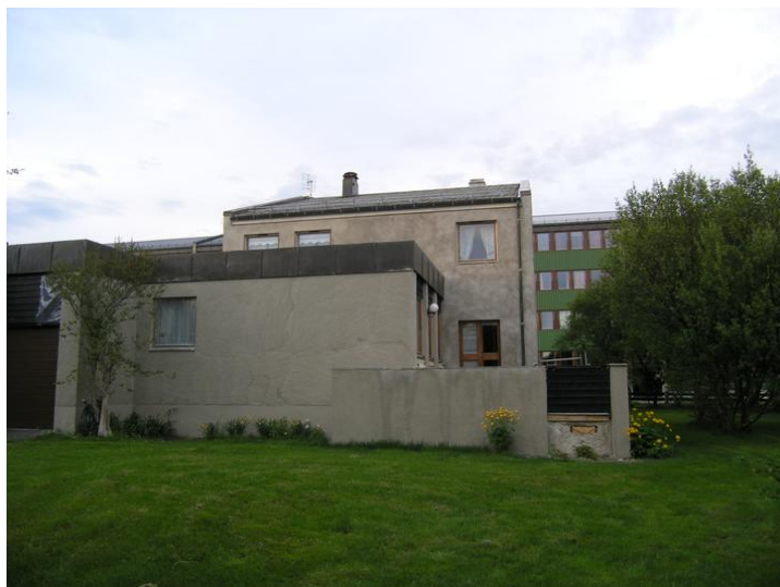
Fasade vest. Garasjeport til venstre. Opphavsrett: Statsbygg.
