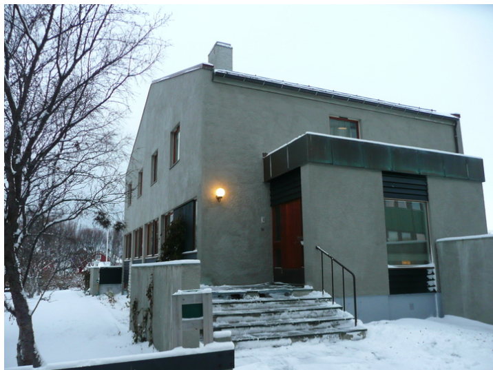
Fylkesmannsboligen. Fasader mot øst og sør. Opphavsrett: Statsbygg.
