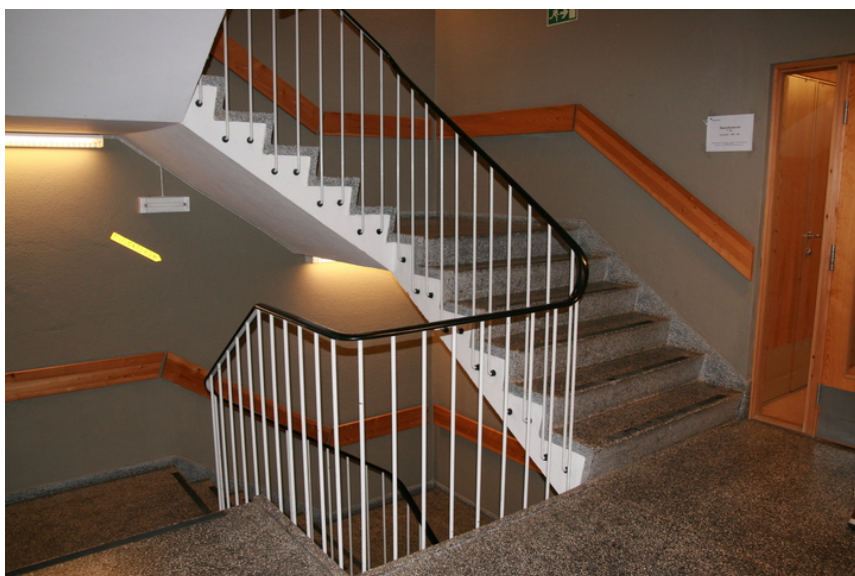
Hovedtrappeløpet i begge blokkene er tidstypisk med terrazzo gulv, enkelt rekkverk og malte murvegger. Her i blokk A. Opphavsrett: Statsbygg.
