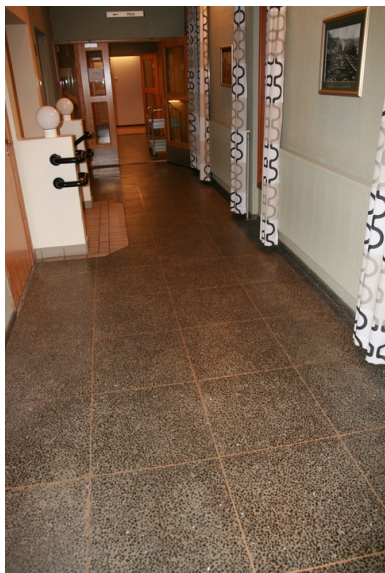
Inngangspartiet sett mot blokk A. Opprinnelig gulv i terrazzo. Opphavsrett: Statsbygg.
