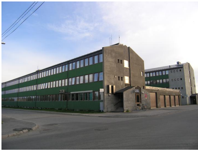
Gavlveggene mot nordøst. Politiets inngang midt i bildet. Opphavsrett: Statsbygg.
