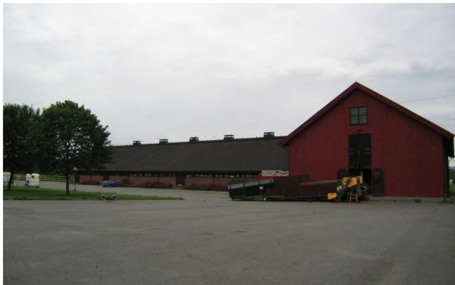
Fasade sørvest. Opphavsrett: Statsbygg.
