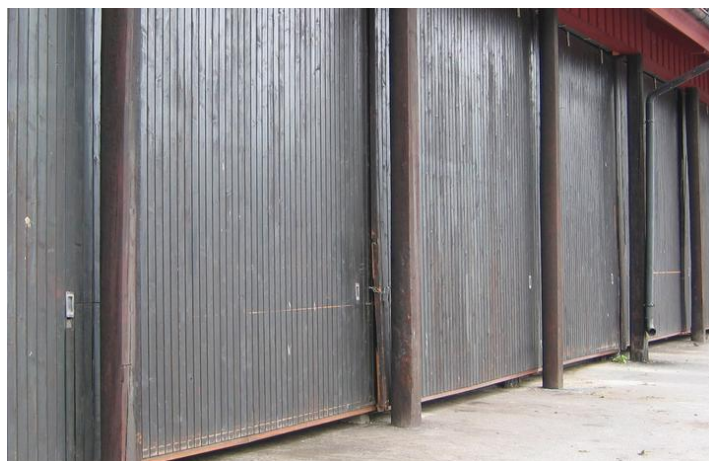
Detalj porter - nordøst fasade. Opphavsrett: Statsbygg.
