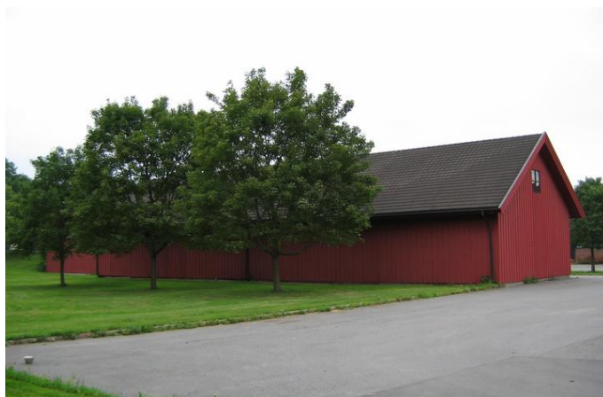
Fasade sørvest. Opphavsrett: Statsbygg.
