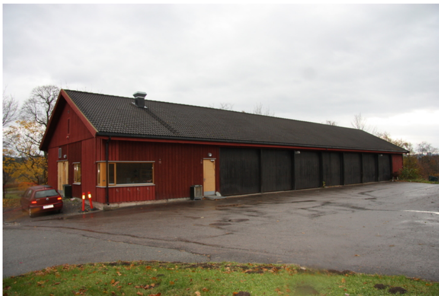
Garasje. Opphavsrett: Statsbygg.
