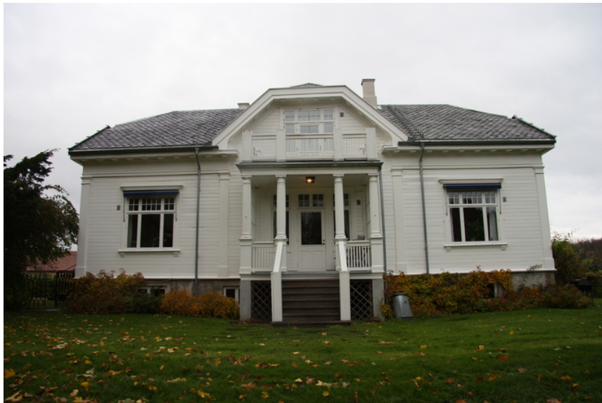
Hovedfløyens fasade mot sørvest og hagen. Opphavsrett: Statsbygg.
