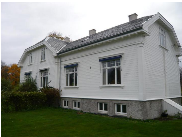
Fasaden mot sørøst vender mot hagen. Sidefløyen er nærmest i bildet. Opphavsrett: Statsbygg.
