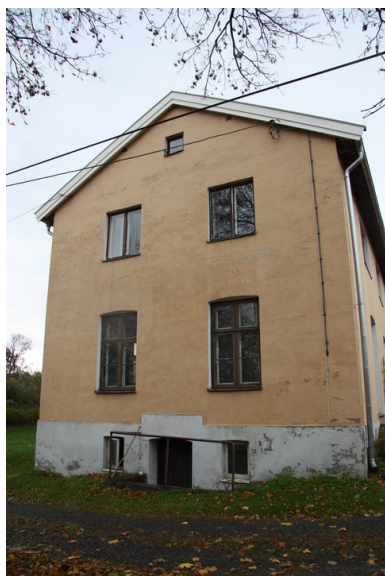
Fasade mot nordvest. Opphavsrett: Statsbygg.
