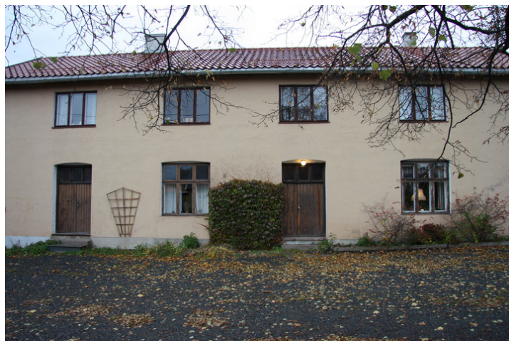
Fasade mot sørvest med verkstedsinngang til venstre og inngang til trapperom mot høyre. Opphavsrett: Statsbygg.
