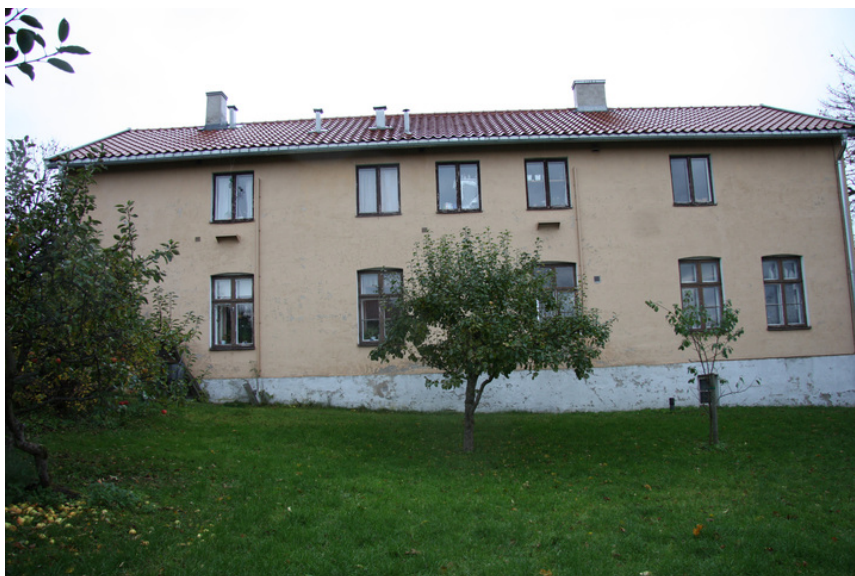
Fasade mot nordøst og hagen. Opphavsrett: Statsbygg.
