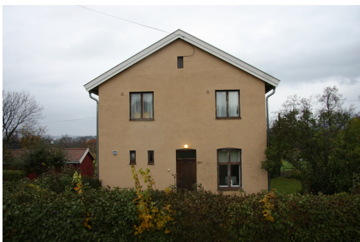
Fasaden mot sørøst har inngang til den ene leiligheten i første etasje. Opphavsrett: Statsbygg.
