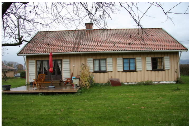
Baksiden med platting vender mot sørøst. Opphavsrett: Statsbygg.
