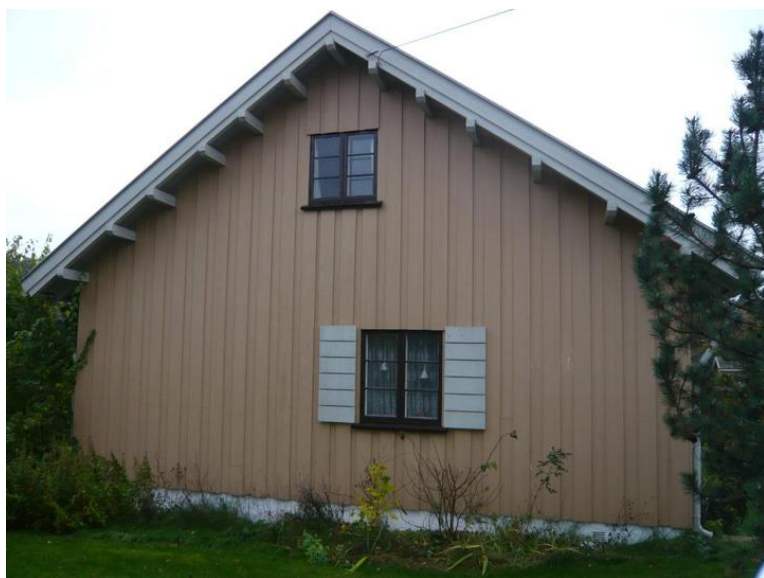
Sørvestfasaden. Gavlen har takutstikk med synlige åser. Opphavsrett: Statsbygg.
