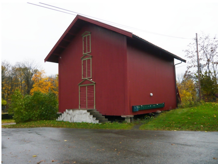
Stabburet på gårdstunet. Opphavsrett: Statsbygg.
