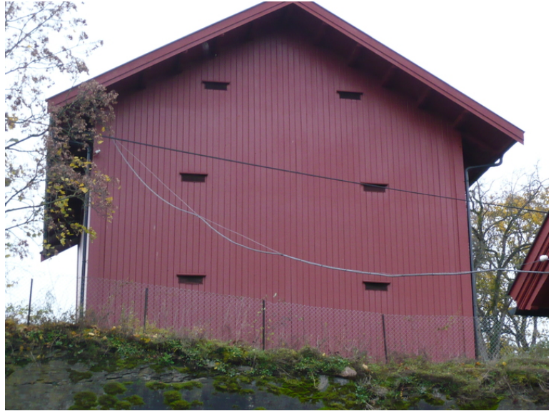
Fasaden mot nordvest. Opphavsrett: Statsbygg.
