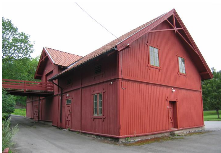
Fasader mot sørøst-nordøst. Opphavsrett: Statsbygg.
