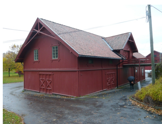
Gavlvegg mot sørvest og langvegg med kjørebru mot sørøst. Opphavsrett: Statsbygg.
