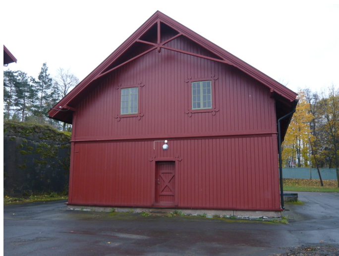
Gavlvegg mot nordøst. Opphavsrett: Statsbygg.
