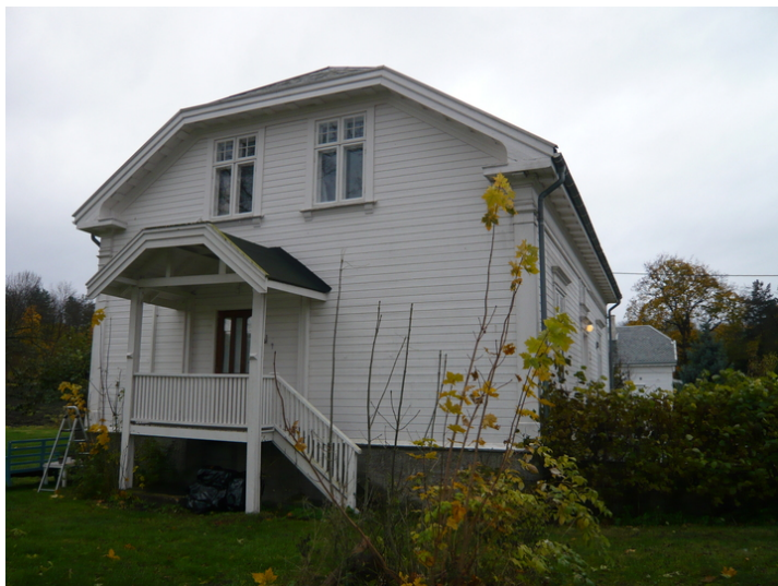
På nordøstfasaden er inngangspartiet. Opphavsrett: Statsbygg.
