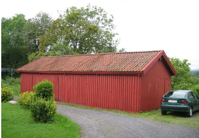
Fasade sørøst. Opphavsrett: Statsbygg.
