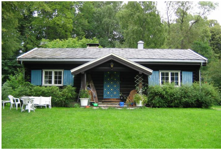
Fasade øst. Opphavsrett: Statsbygg.
