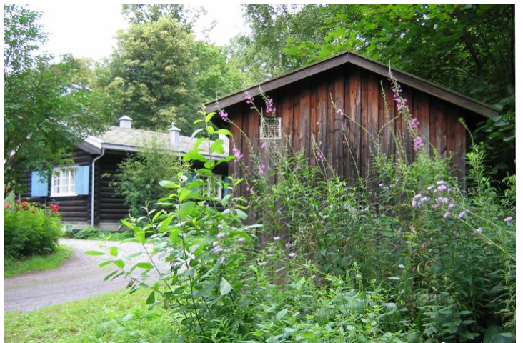
Hovedhus fasade nord med Uthus. Opphavsrett: Statsbygg.
