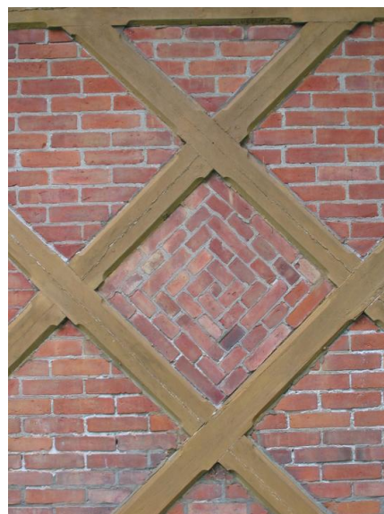
Bindingsverket er lagt diagonalt og teglsteinen er brukt på dekorative måter. Opphavsrett: Statsbygg.
