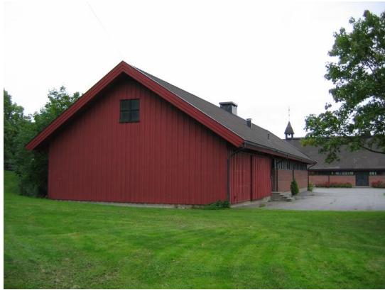
Fasade sørvest-sørøst. Opphavsrett: Statsbygg.
