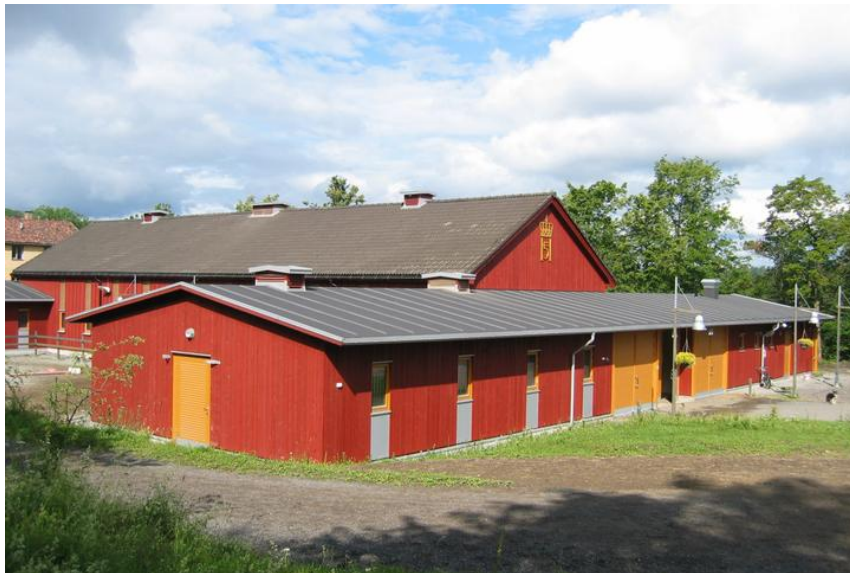
Fasade sørvest. Opphavsrett: Statsbygg.
