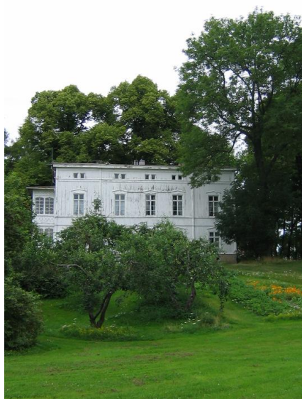
Fasade øst, mot hovedadkomsten. Opphavsrett: Statsbygg.
