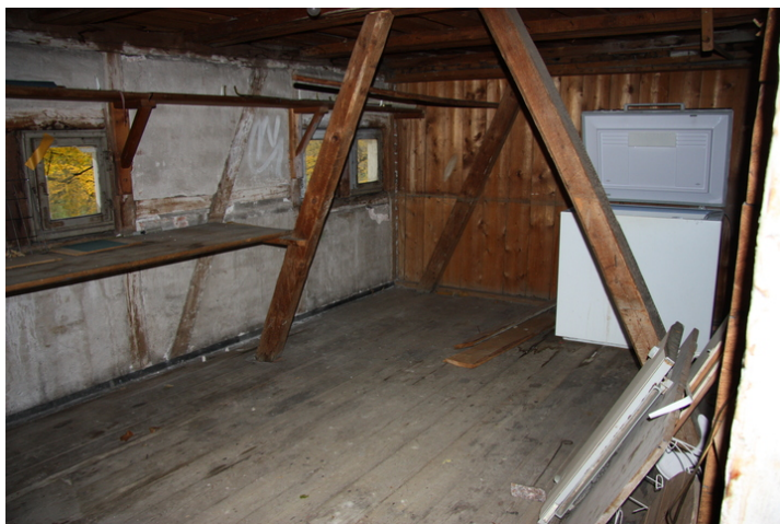
Loft. Bygningen ble i påbygg med loftsetasje i utmurt bindingsverk i 1840/50-årene. Opphavsrett: Statsbygg.
