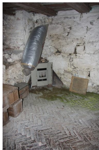
Teglgulv i to kjellerrom. Opphavsrett: Statsbygg.
