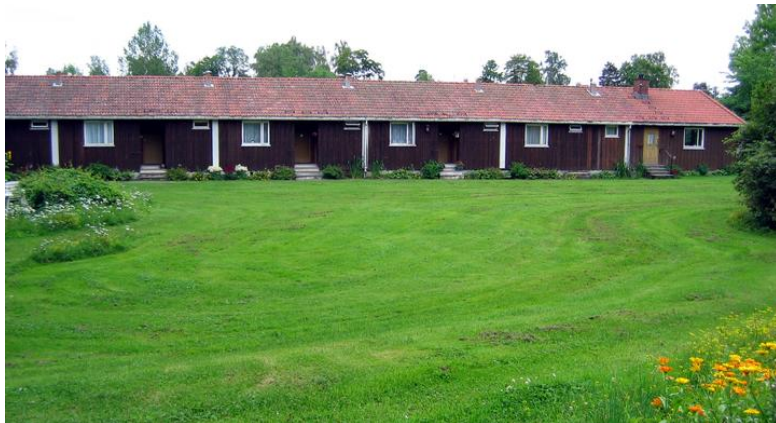
Fasade nord. Opphavsrett: Statsbygg.
