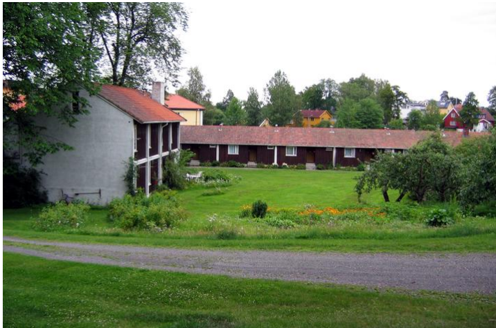
Fasade nordvest. Pensjonistbolig I og II sett fra Strømsborg. Opphavsrett: Statsbygg.
