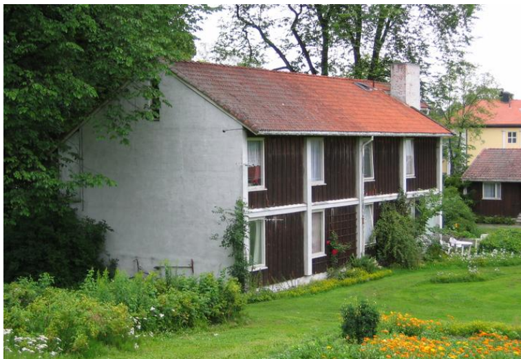
Fasade nord vest. Opphavsrett: Statsbygg.
