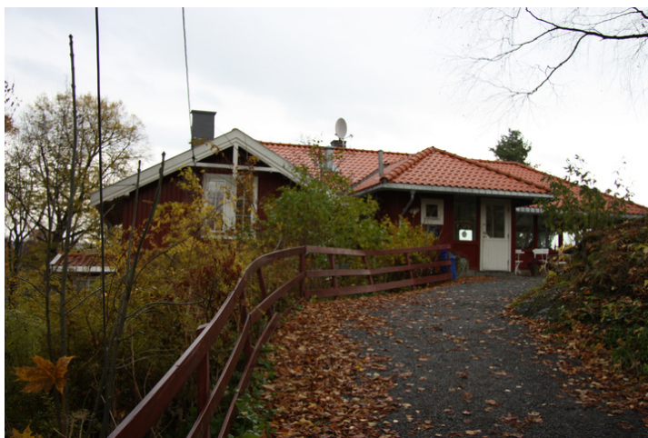
Adkomstveien er fra sørvest. Opphavsrett: Statsbygg.
