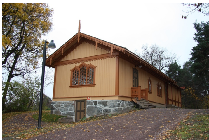
Fasader mot adkomsten. Opphavsrett: Statsbygg.
