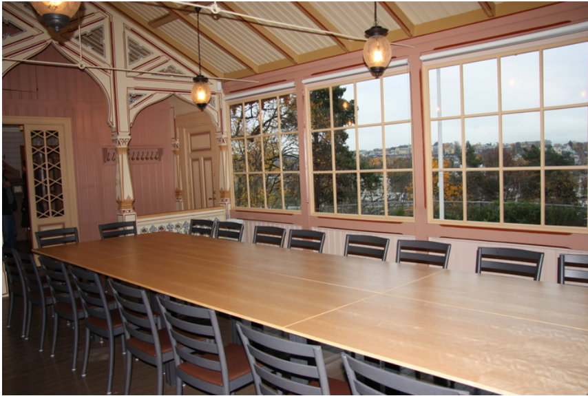
Glassverandatilbygget mot badehusdelen. Opphavsrett: Statsbygg.
