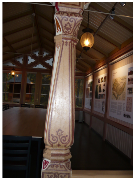
Stolpe med dekor fra bygningen ble tatt i bruk til kafédrift. Opphavsrett: Statsbygg.
