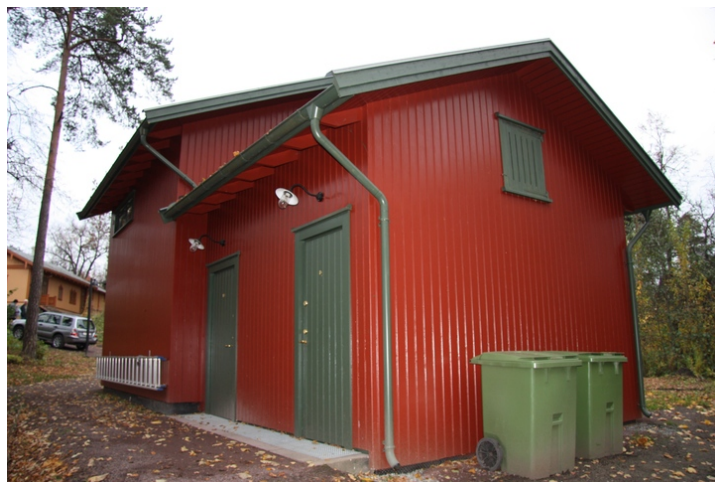
Uthusets bakside. Sæterhytten sees i bakgrunnen. Opphavsrett: Statsbygg.
