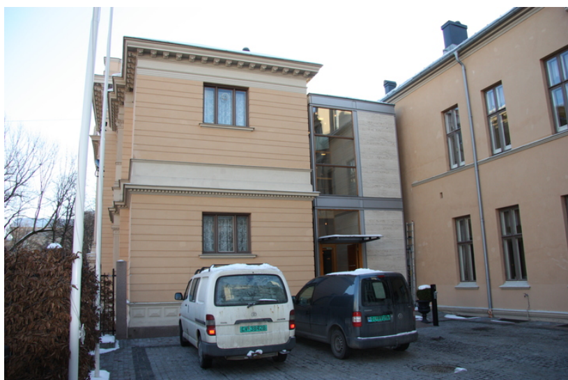
Nordvestfasaden med nyere inngangsparti oppført ca 1997. Opphavsrett: Statsbygg.
