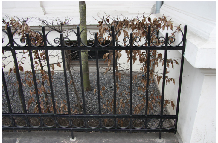
Opprinnelig smijernsgjerde utenfor Riddervoldsgate 2. Opphavsrett: Statsbygg.
