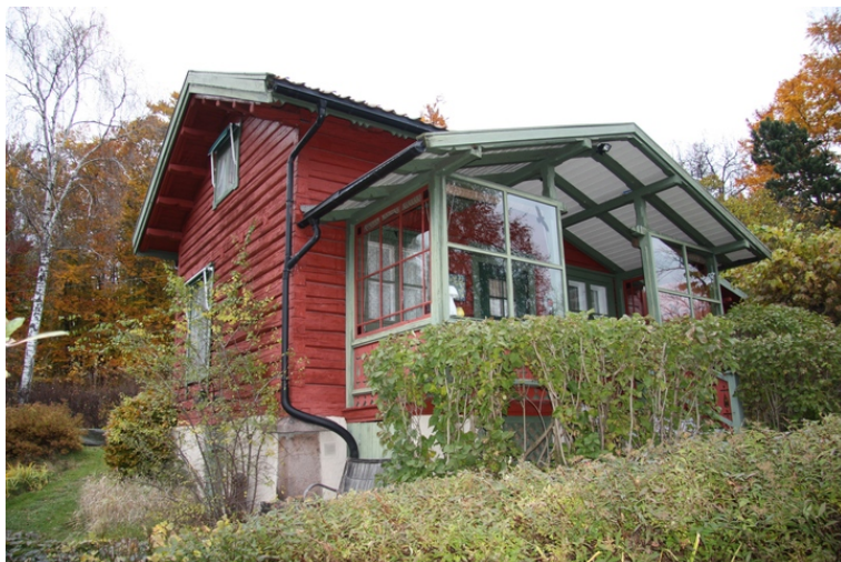
Stabbur. Fasade mot øst. Opphavsrett: Statsbygg.
