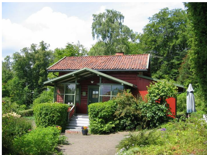
Stabburet på Hengsen. Fasade mot øst. Opphavsrett: Statsbygg.
